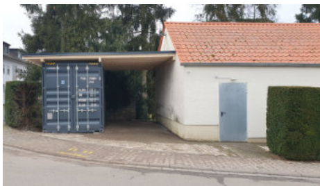
Materialcontainer mit Überdachung
